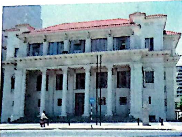
Edifício de um banco em Maputo.
