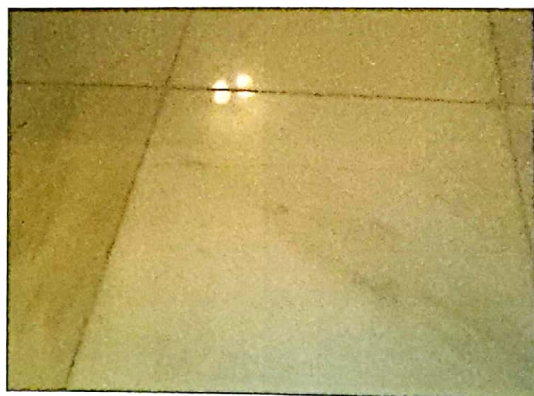
Fig. 173 Pavimento em mármore
